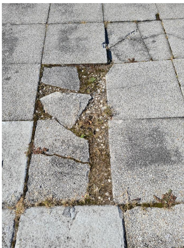
Photo d'une zone de dalles fortement dégradées
